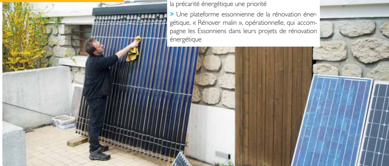
Rénovation énergétique d'un pavillon à Morangis.
