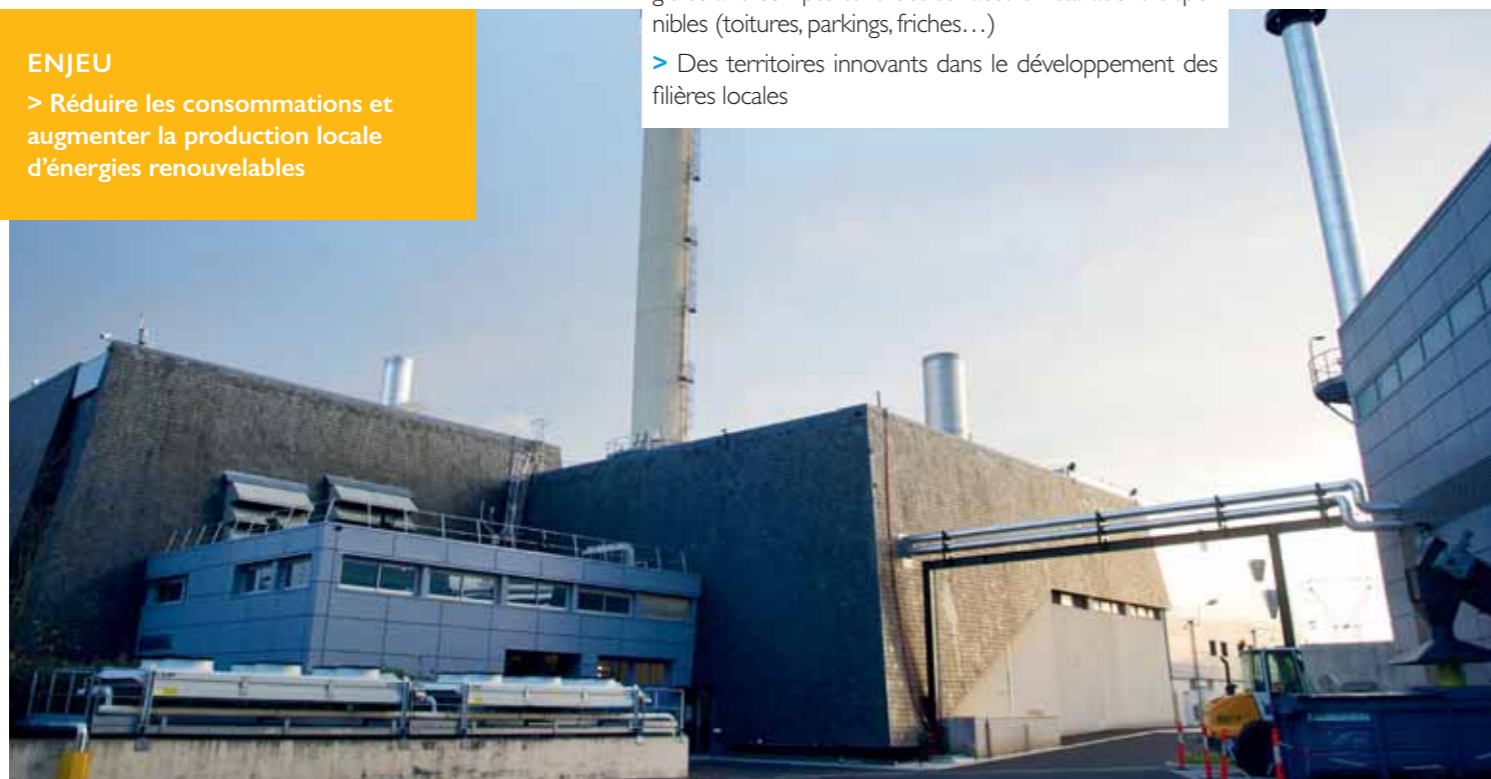
Chaufferie biomasse aux Ulis.
