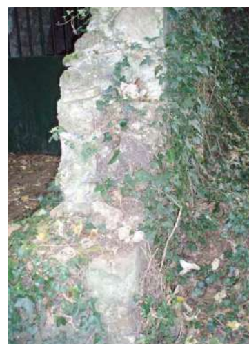
Arase du mur du petit vestibule d'entrée
