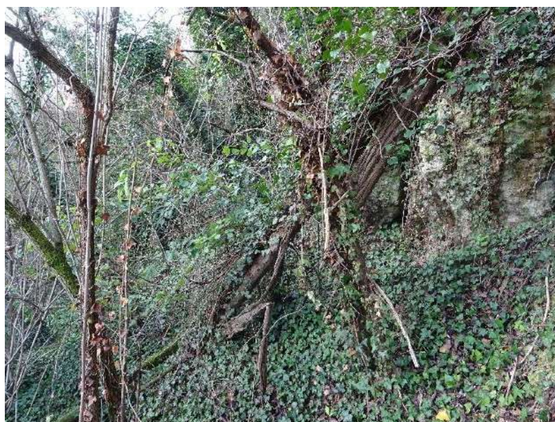
Figure 1. Vue partielle d'une falaise calcaire au sein des Roches-Saint-Jean
