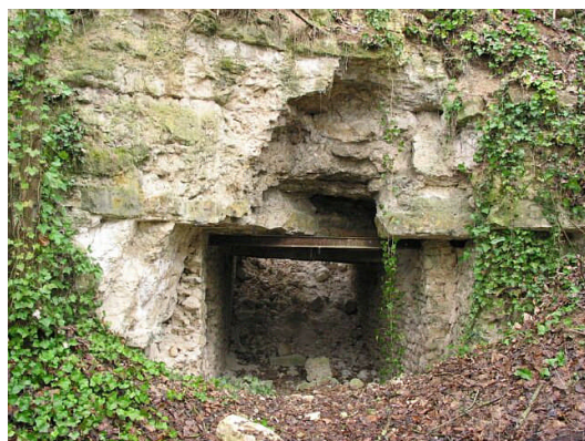
Fig. 12 - Le « tunnel », ancienne entrée de la carrière.
