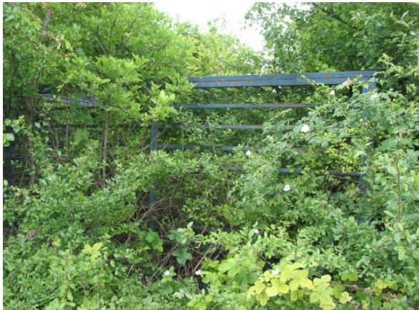
Fig. 22 – Cage de protection de la margelle du puits d'aération.
