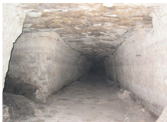
Fig. 13 - Galerie nord, 135 m de longueur.
