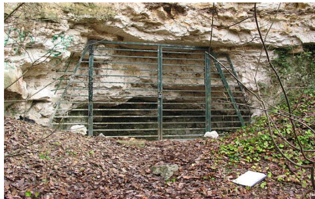
Fig. 23 – Grille de protection de l'entrée 1
