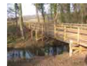
Passerelle le long du Rû des Hauldres
