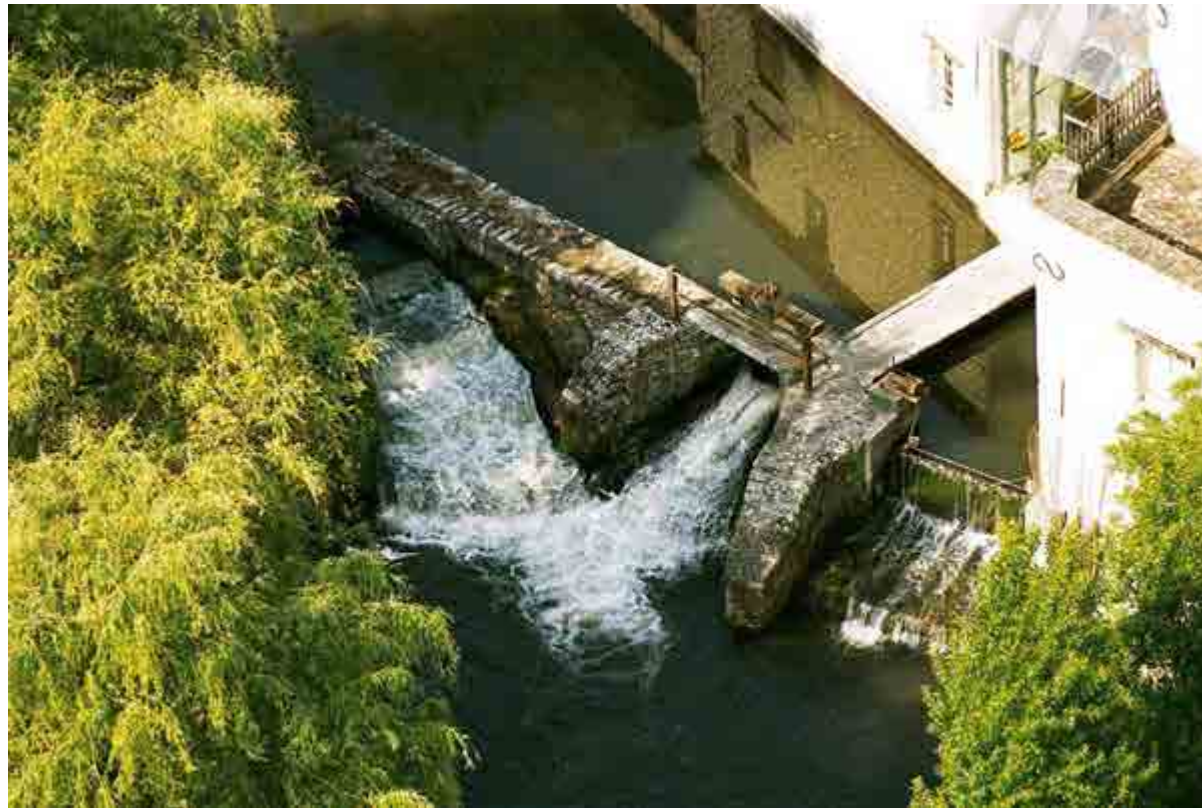
Ouvrage hydraulique à Gironville-sur-Essonne
