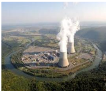
Rejets des installations
