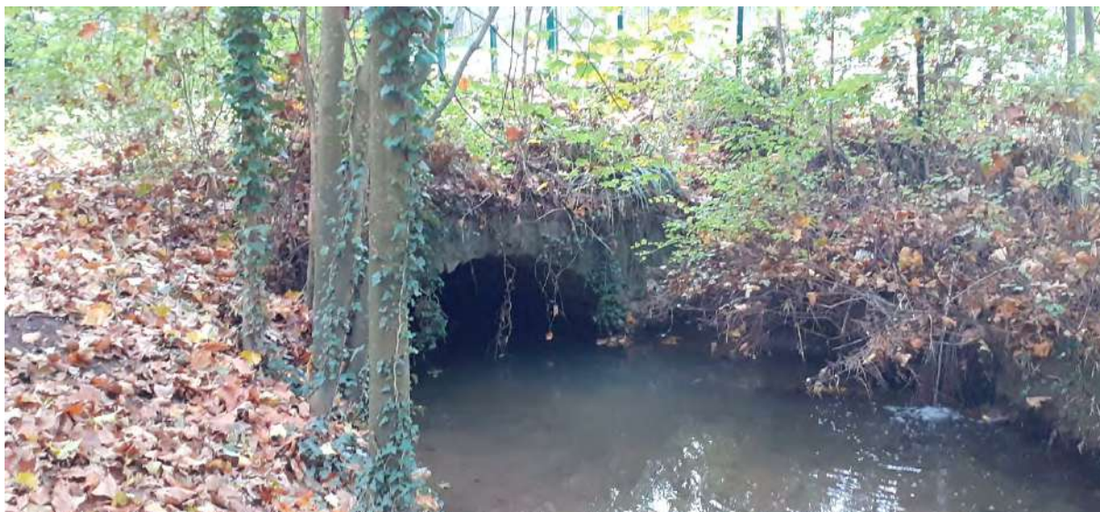
Fig. 71-72 : Ponceau sur la Salmouille en limite de Marcoussis, XVII e siècle
