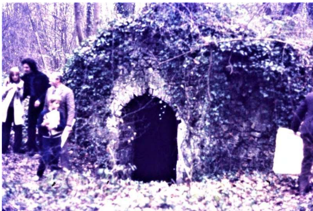
Fig. 49 : État de la source de Bellejame en 1976, cl. Fr. Fort, A.H.M.
