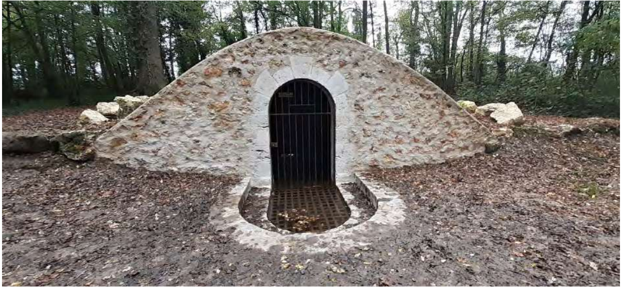
Fig. 84 : Entrée de la source
