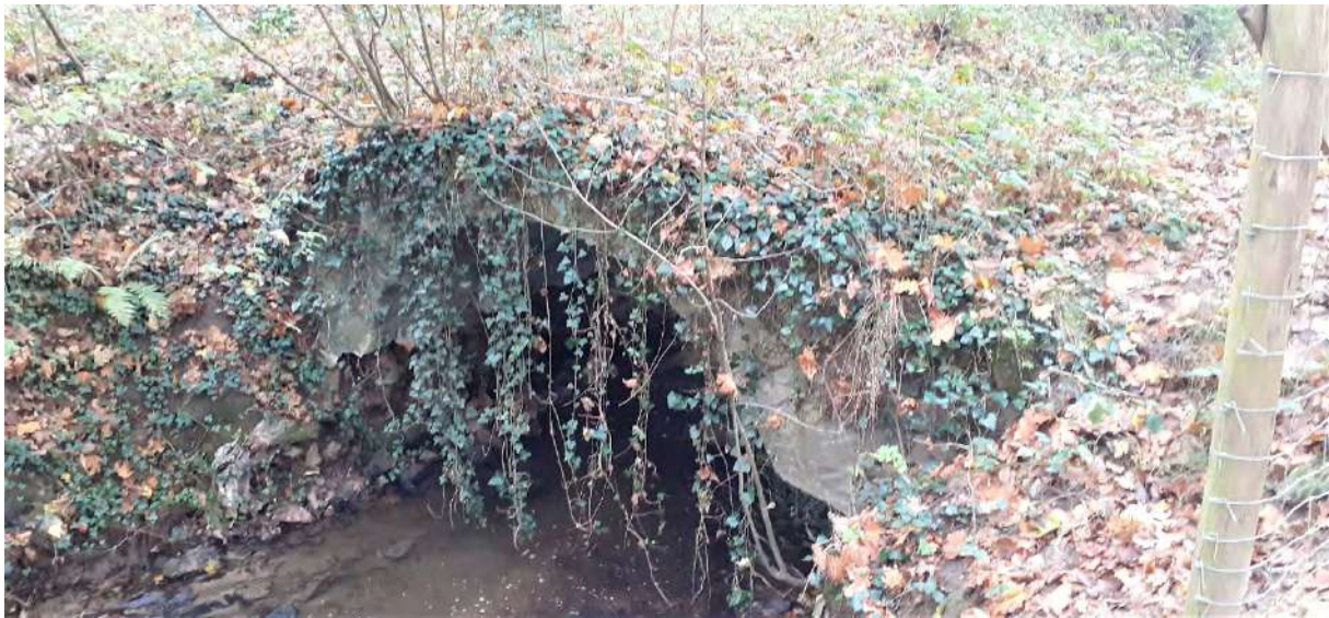
Fig. 73-74-75 : Pont sur la Salmouille, XVII e siècle, état actuel
