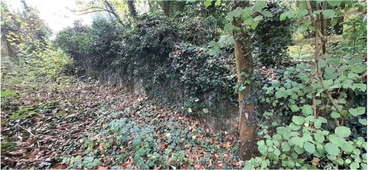
Fig. 116 : Vestiges du mur de clôture à l'est du parc
