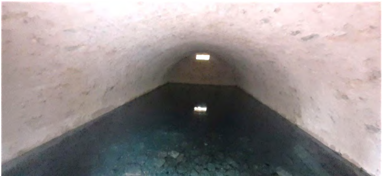
Fig. 85 : Le bassin et sa voûte restaurés
