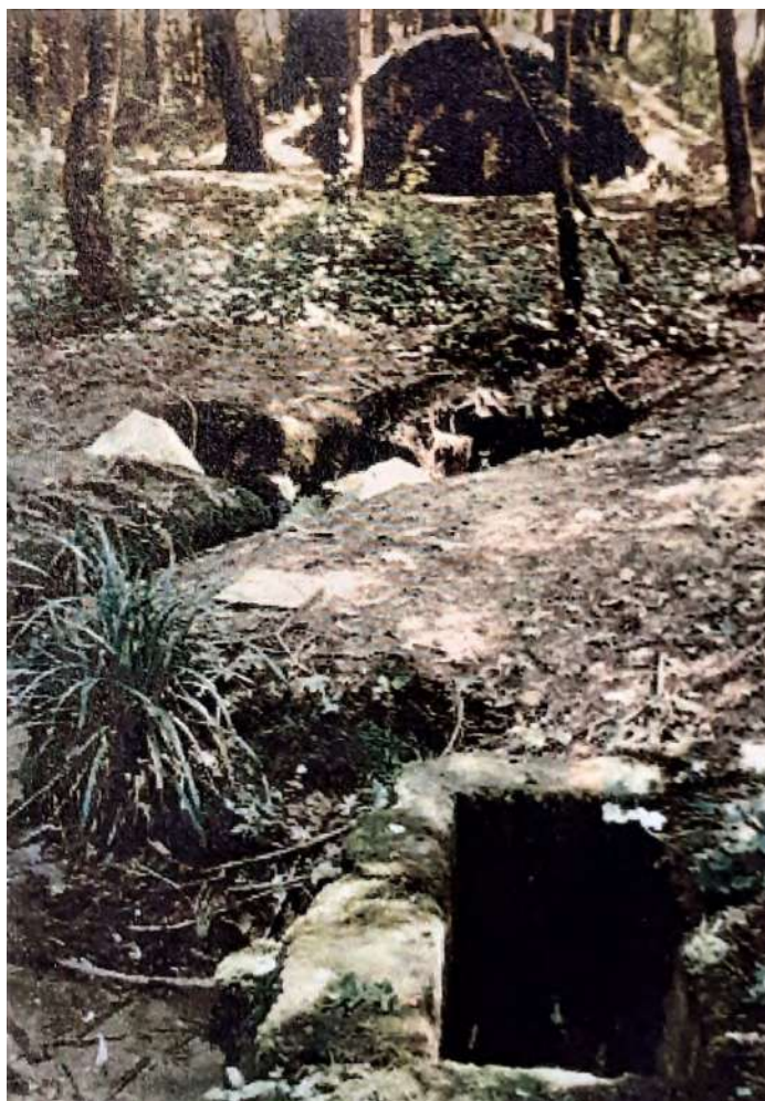
Fig. 53 : La source et le réseau hydraulique du parc, vestiges, 1997, cl. A. Deschar, 1998, t. II, fig. 91
