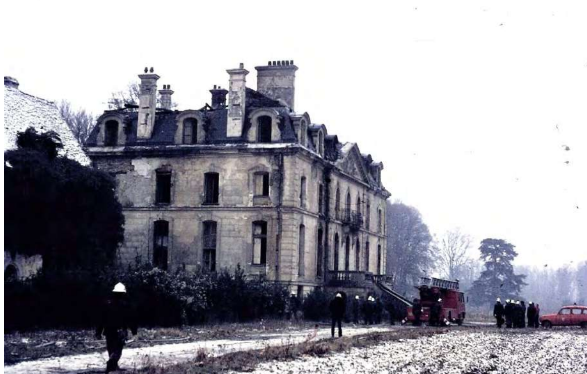
Fig. 41-42 : Incendie des combles du château à l'hiver 1976, cl. Fr. Fort, A.H.M.
