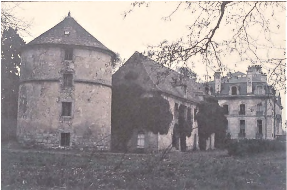
Fig. 38 : Les bâtiments de Bellejame en janvier 1971, cliché Georges Poisson, AD 91, 1 J 800
