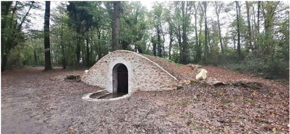
Fig. 82 : La source restaurée du côté de l'entrée
