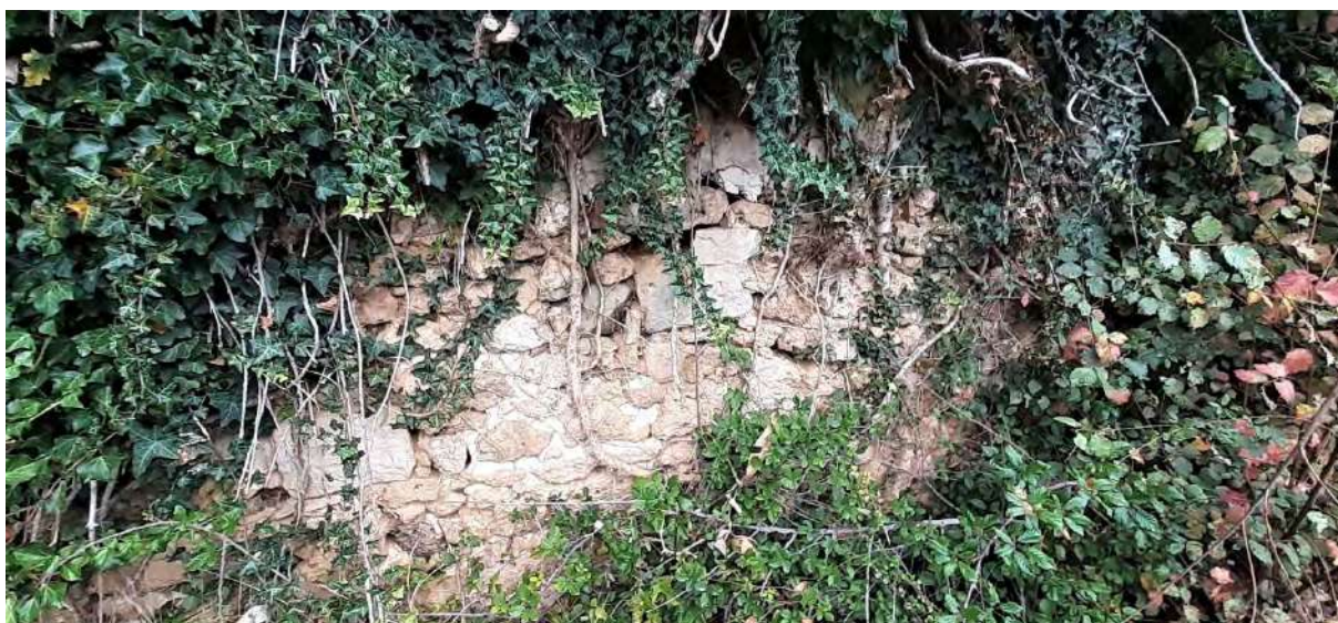
Fig. 113 : Détail de la maçonnerie XVII e
