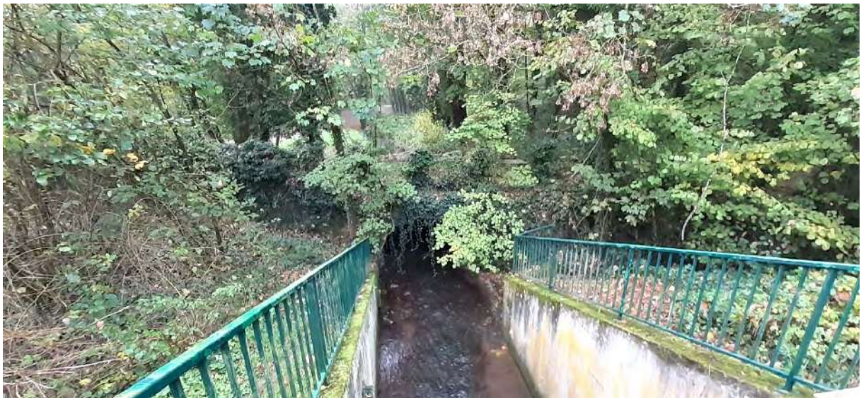
Fig. 79-80-81 : La Salmouille au droit du ponceau et de la digue ensuite à l'est du parc
