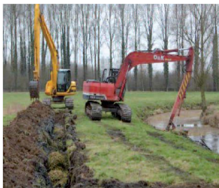
Arrachage mécanique et enfouissement réalisés par l'USAN ©USAN
