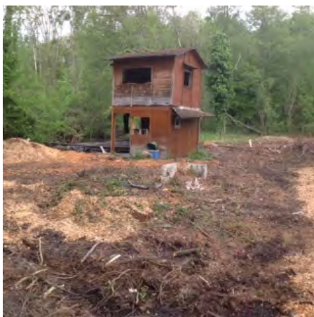
Cabanon avant démolition
