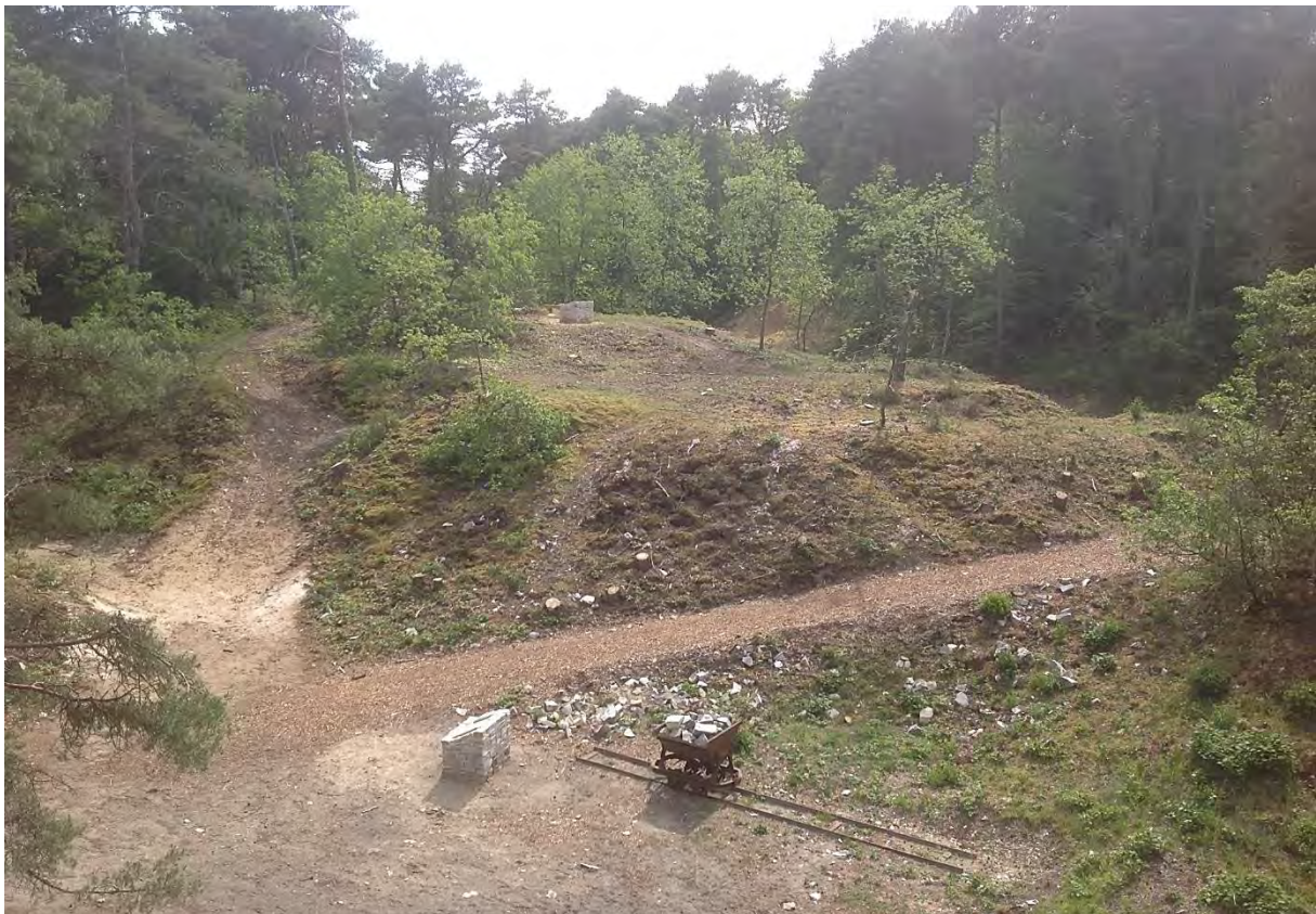
Travaux de réouverture de milieux sur le site de la Butte du Puits
