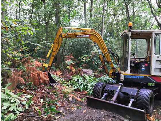
Arrachage mécanique de Lauriers
