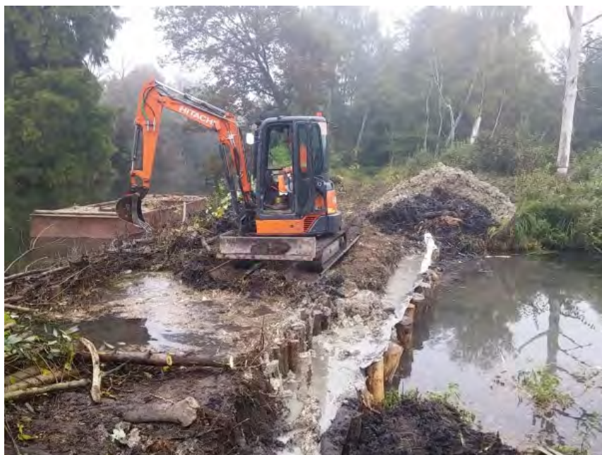
Traitement de « renard » hydraulique (brèche en berge)
