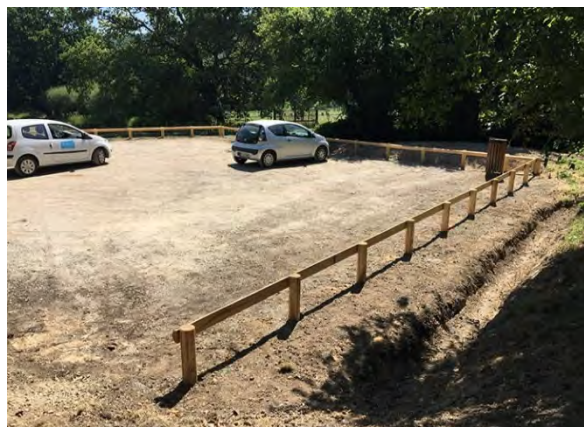
Reprise du parking à Villiers-le-Bâcle (Bois des Grais)
