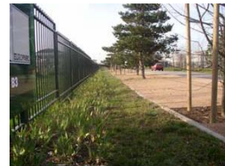
Parking avec noue végétalisée permettant la dépollution des hydrocarbures
