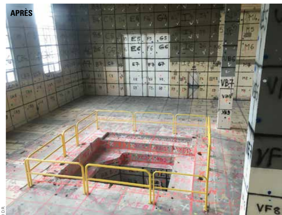
Opération de démantèlement totalement achevée fin 2019, avec le retrait du réacteur et de la dalle en béton. Les indications sur les murs représentent la cartographie de l'ensemble du hall. Dans chaque zone, l'absence totale de radioactivité est vérifiée, en surface et dans la masse.
