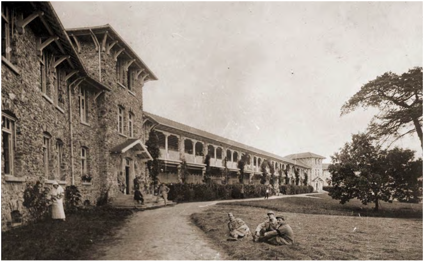
18 - Sanatorium de Bligny. - Collection de l'hôpital de Bligny.
