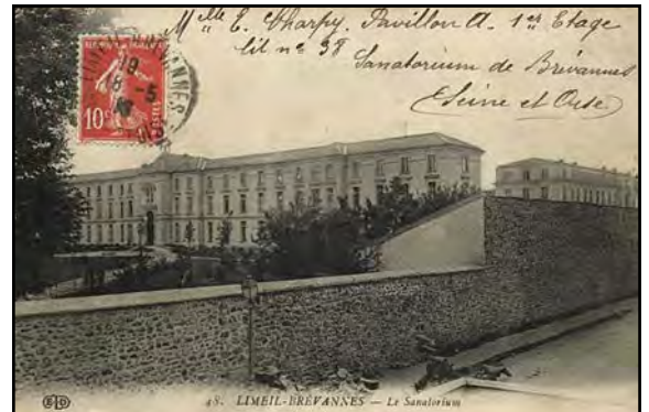
14 - Sanatorium de Limeil-Brevannes.
